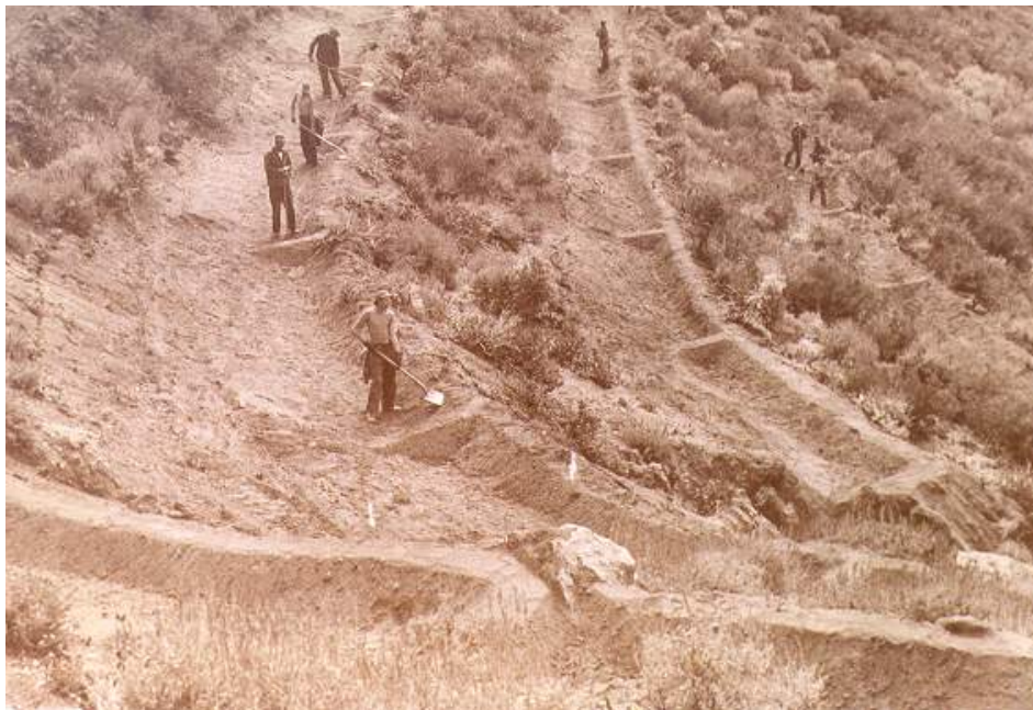
Figura I.10. Construcción de caballones según curvas de nivel cerca de Farmington (Utah, Estados Unidos) por el U.S. Forest Service en 1933 (Ponce, 2003b)
